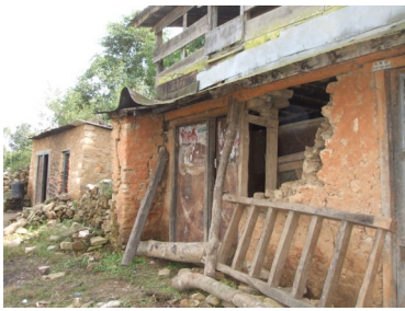
被災し壊れたままの民家
